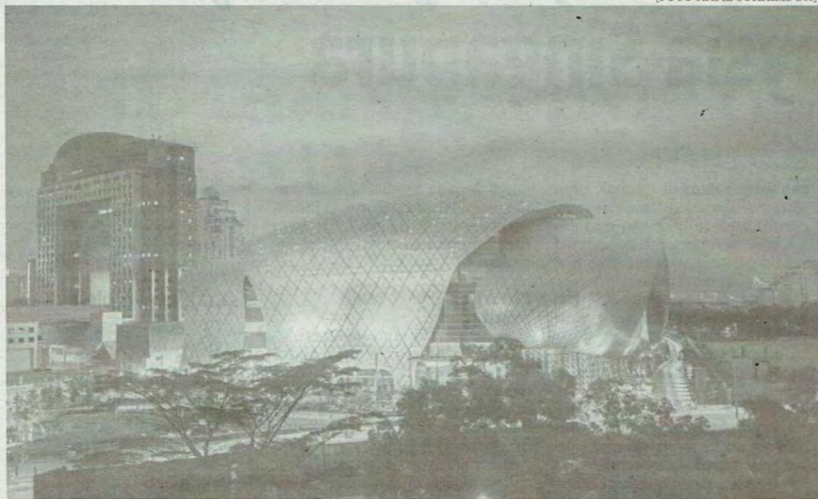
Bangunan MITEC di Jalan Dutamas 2 jadi ikon kejayaan syarikat Bumiputera.
